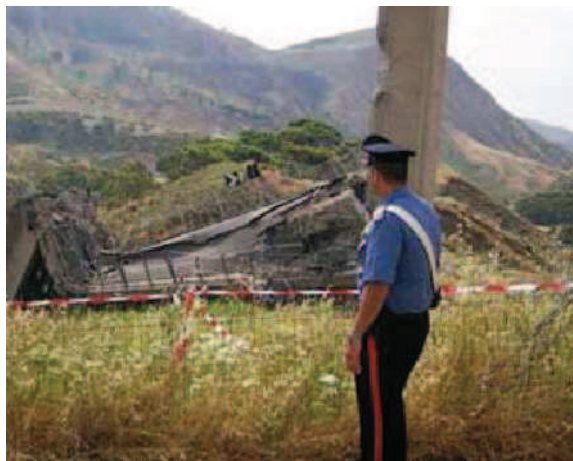
Un militare dell'Arma ai piedi del viadotto crollato
